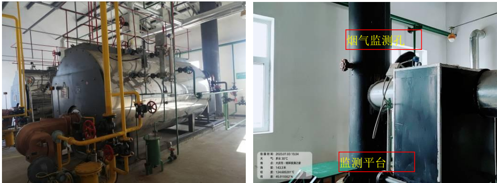
辅助厂房内锅炉房区（葡一联卸油点隐患治理工程项目新建的 2 台 WNS3-1.25-Y(Q)燃气蒸汽锅炉（1 用 1 备））
