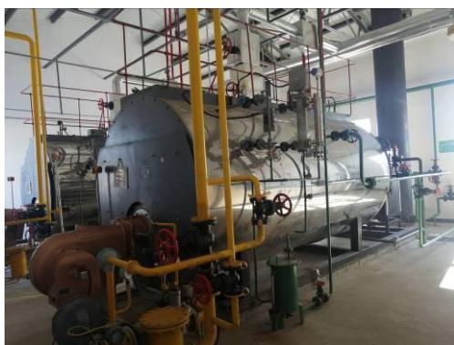
(11) 辅助厂房内锅炉房区（葡一联卸油点隐患治理工程项目新建的2台 WNS3-1.25-Y(Q) 燃气蒸汽锅炉（1用1备））
