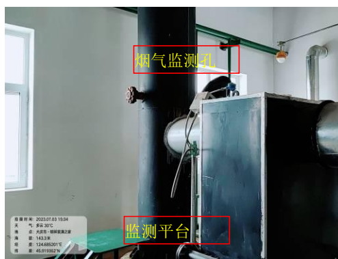
(12) 辅助厂房内锅炉房区（葡一联卸油点隐患治理工程项目新建的2台 WNS3-1.25-Y(Q) 燃气蒸汽锅炉（1用1备））
