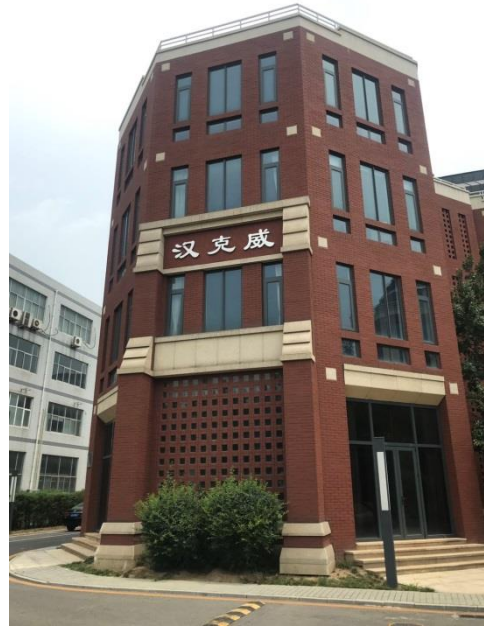
项目西侧照片（北京汉克威测控系统有限公司）
