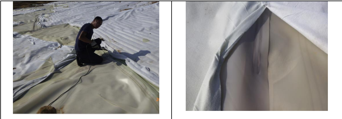
灰场底部两布一膜防渗土工布铺设
