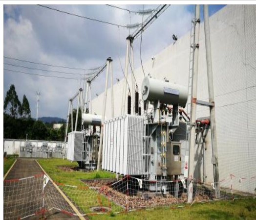
主变压器下集油坑
